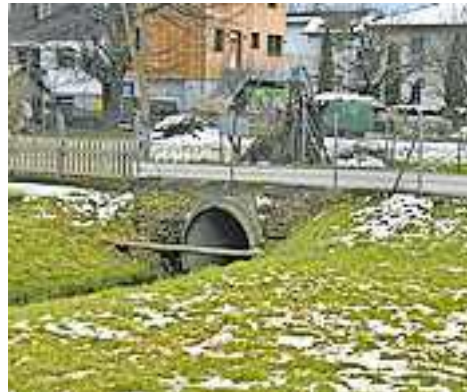
Die Verrohrung wird durch eine neue Brücke ersetzt
