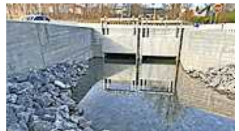
Die neuen Schleusentore an der Landesstraße L57
